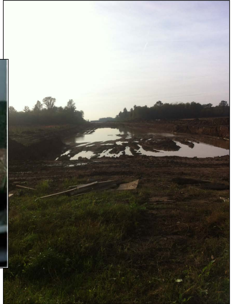
Foto 26/10/2013 – cantiere A.P.L. area a sud della località Braghe, Lomazzo
