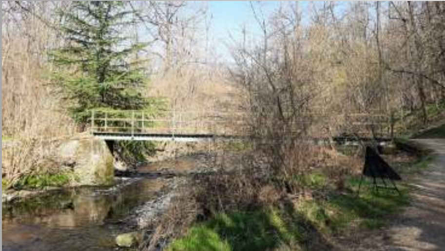
Ponte degli Alpini esistente ubicato in comune di Cadorago.
